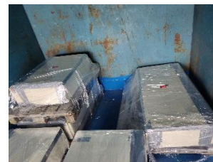
Abb.3 fachgerecht verpackte Nachtspeichergeräte
